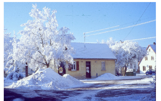
Radelstetten // Backhaus vor 1997
